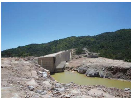
Corpo da barragem executado e paramento de montante, visto a partir da ombreira esquerda.
