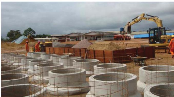
FIGURA 3: VISTA DO CANTEIRO DE OBRAS - SISTEMA NORTE - FÁBRICA DE ANÉIS DE CONCRETO PARA POÇOS DE VISITA
