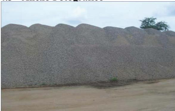
Foto 1 - Estoque de brita advindo da central de britagem da empresa construtora (Trecho 1).
